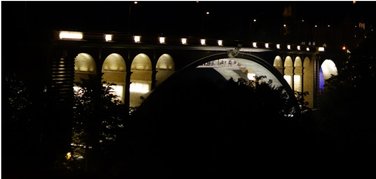
Brücke über den „Grund“
