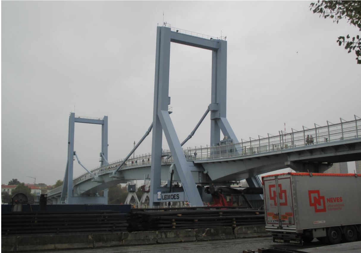
Ponte Movel bei Kilometer 7
