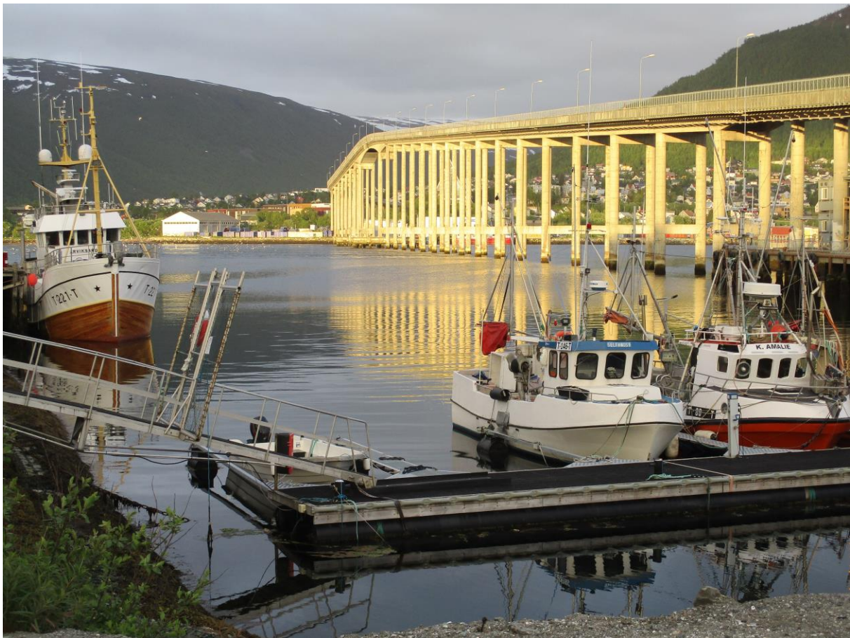
Blick auf die Brücke bei Kilometer 21
